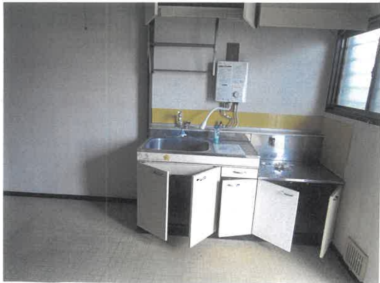
物件5 101号室 キッチンの状況
