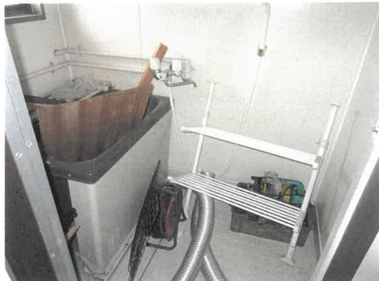
物件5 201号室 浴室の状況
