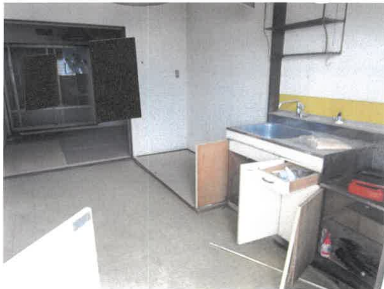
物件5 202号室 キッチンの状況
