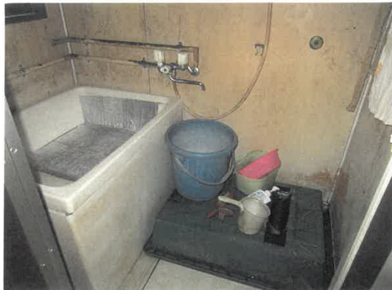
物件5 102号室 浴室の状況
