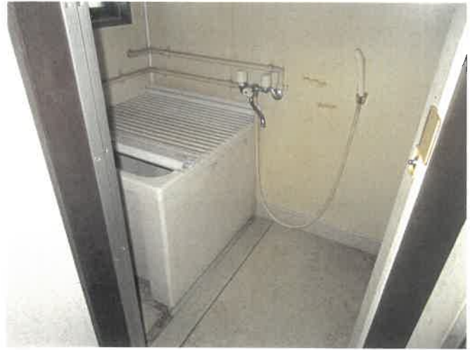
物件5 103号室 浴室 の状況 ⑪
