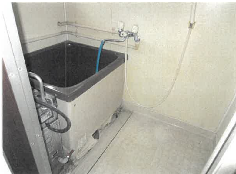
物件5 101号室 浴室の状況
