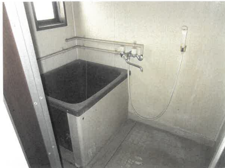
物件5 202号室 浴室の状況
