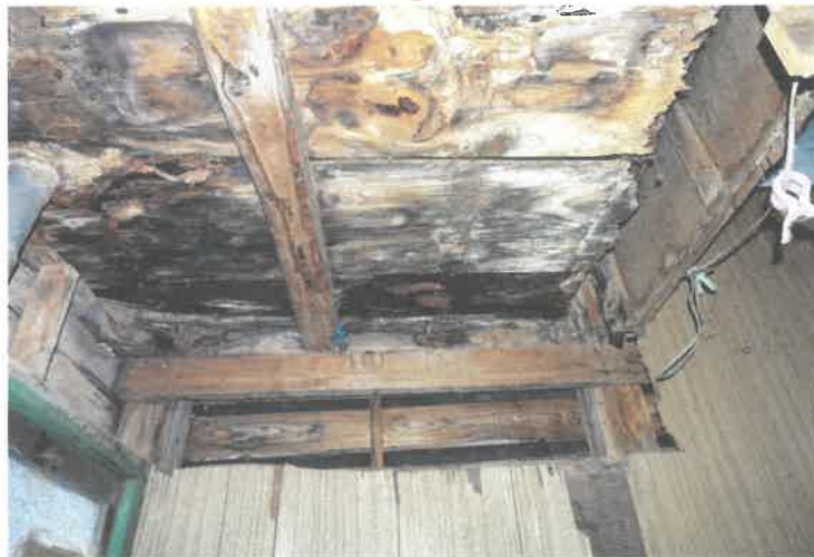
階段天井の状況
