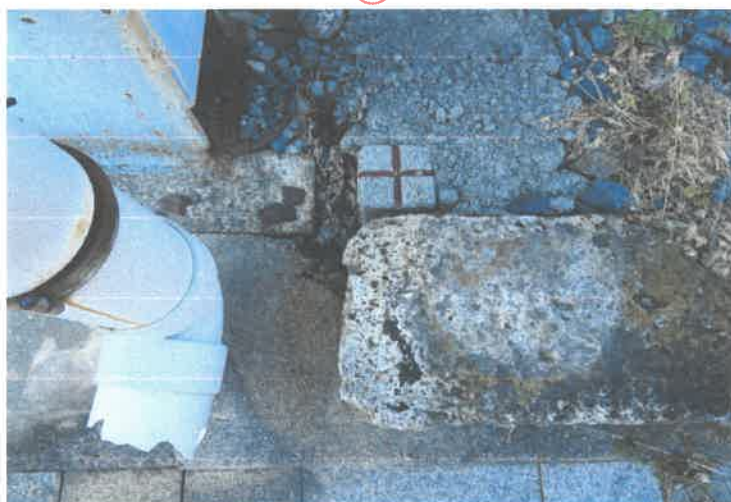
南東角付近のコンクリート杭
