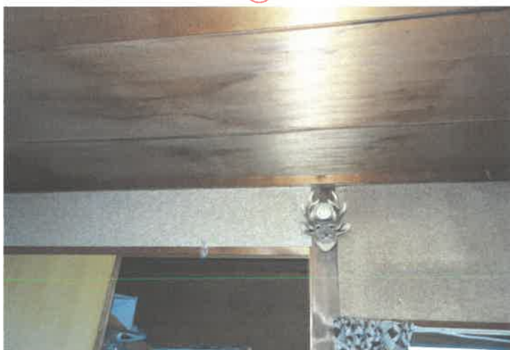
和室天井の状況
