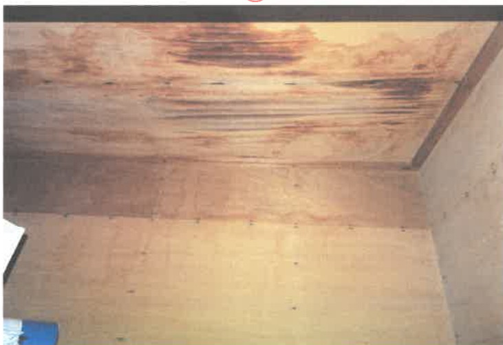
和室押入天井の状況
