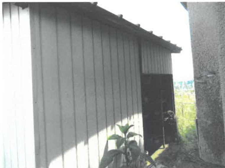
写真12（未登記附属建物2 物置）
