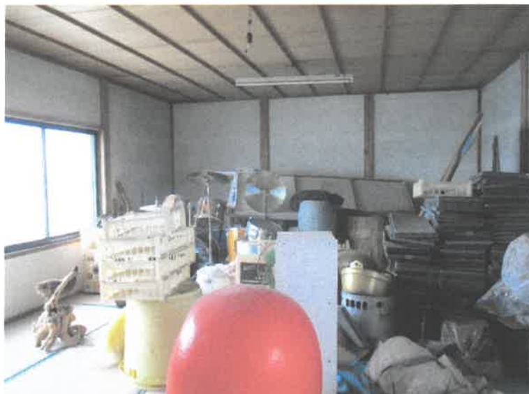
写真11 (物件8 附属建物符号2 内部)
