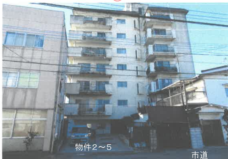
外観(一棟の建物)
