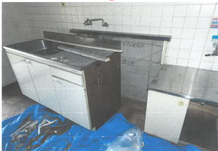
キッチン(排水管修繕中)
