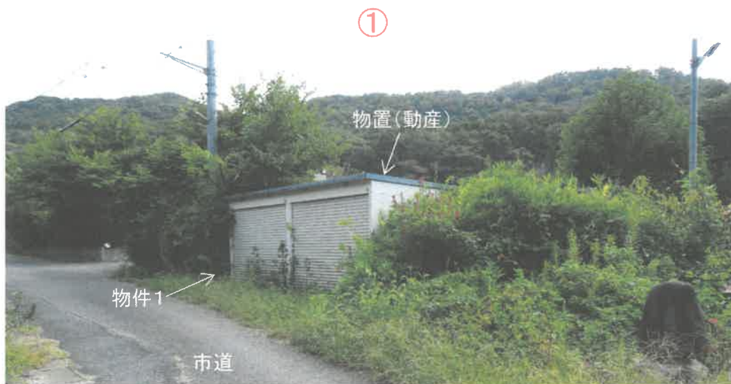
外観(市道側からの状況)
