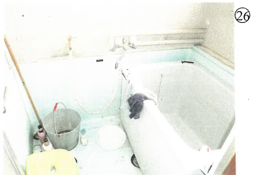
物件2 2階 202号室 浴室の状況
