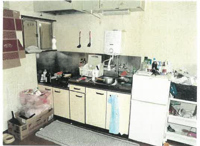
物件2 2階 203号室 キッチンの状況 ②⑨
