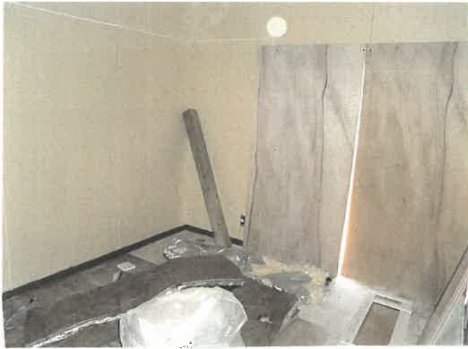
物件2 1階 102号室 洋室の状況 ⑪
