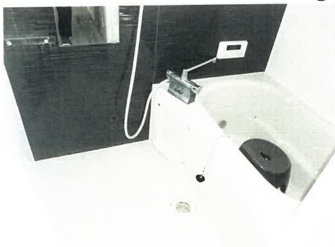
物件2 1階 103号室 浴室の状況
