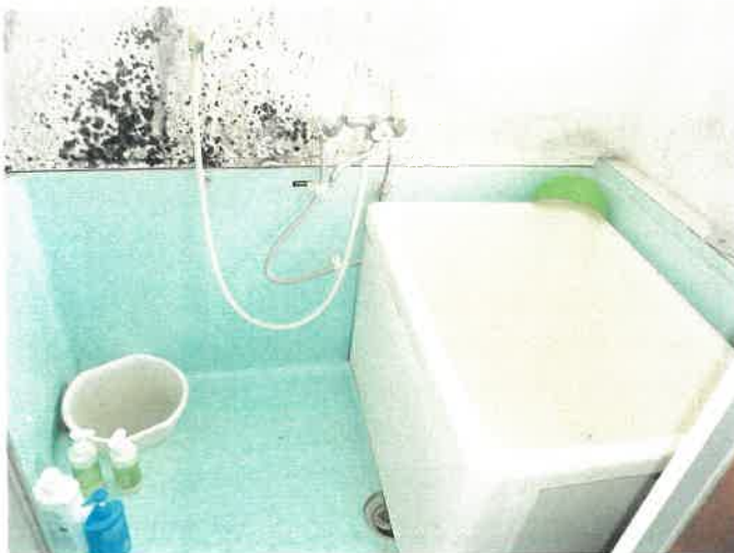
物件2 2階 203号室 浴室の状況 ③⑩
