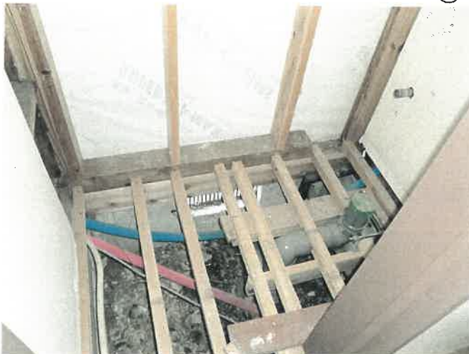
物件2 1階 102号室 トイレの状況 ⑮
