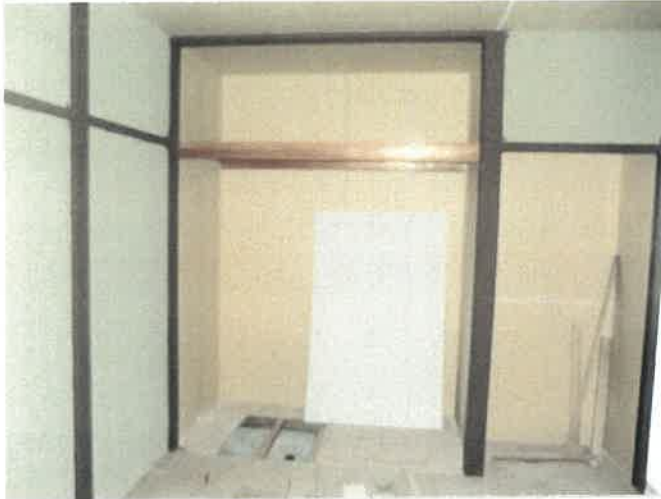
物件2 1階 102号室 和室の状況 ⑬
