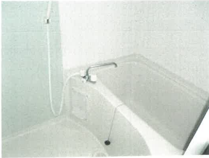
物件4 1階 105号室 浴室の状況 ⑰
