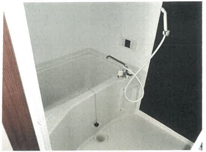
物件4 2階 201号室 浴室の状況 ㉒
