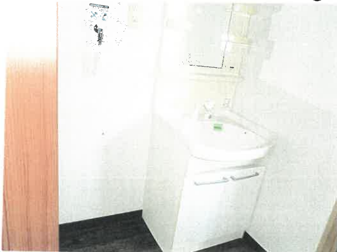
物件4 2階 201号室 脱衣洗面室の状況 ㉑
