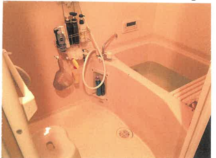
物件4 2階 202号室 浴室の状況 ㉖
