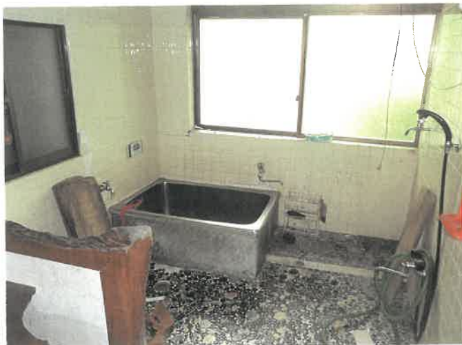
物件7主である建物 1階 浴室の状況 ①9
