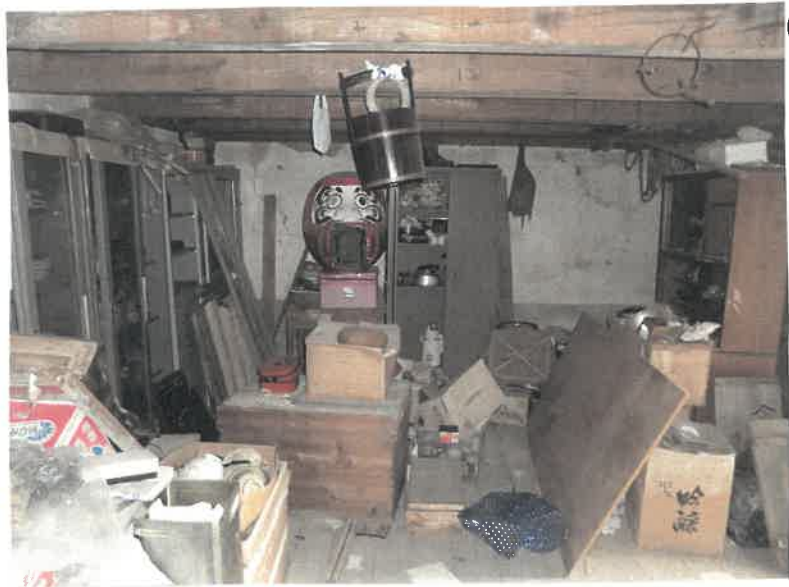
物件7附属建物符号1 1階 倉庫の状況
