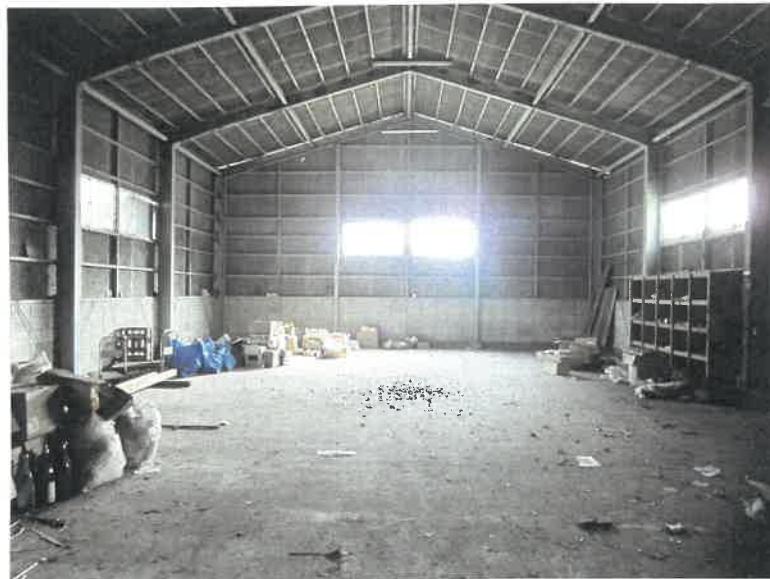
物件8主である建物 倉庫の状況
