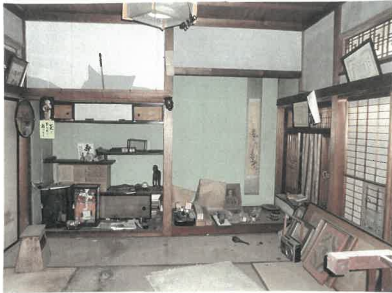
物件7附属建物符号6 和室の状況
