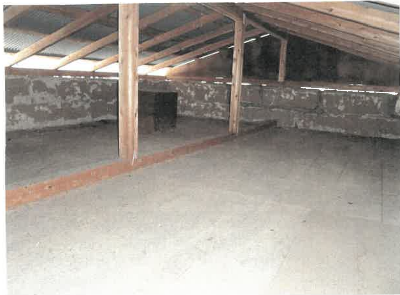
物件7附属建物符号1 2階 倉庫の状況
