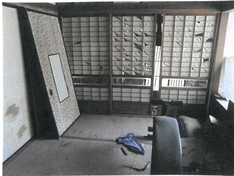
物件7附属建物符号6 和室の状況
