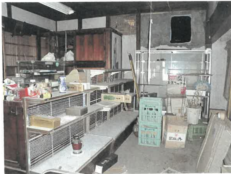
物件7主である建物 1階 店舗の状況
