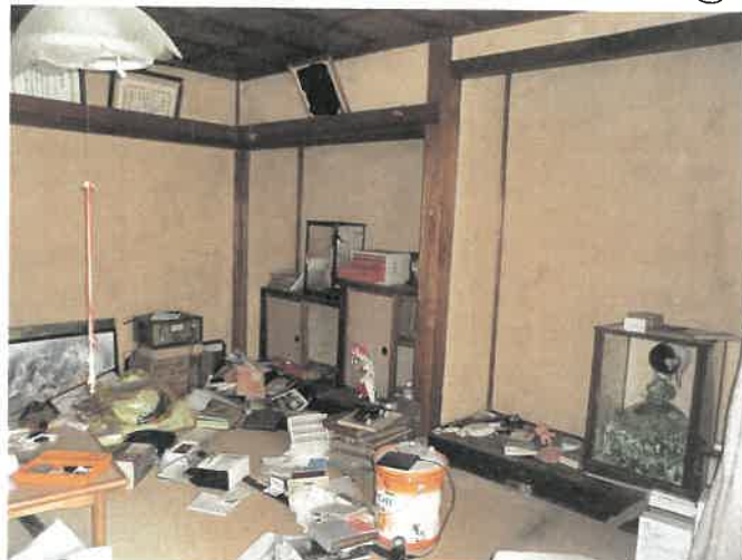
物件7主である建物 2階 和室の状況 ②0
