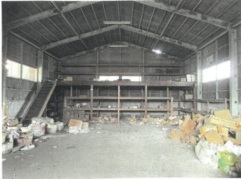
物件8主である建物 倉庫の状況
