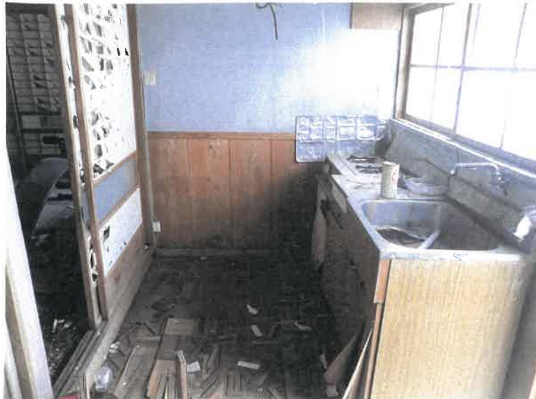
物件7附属建物符号6 台所の状況
