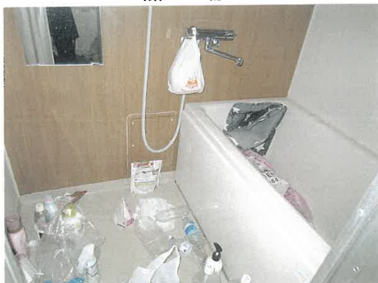
物件10 1階 102号室 浴室の状況
