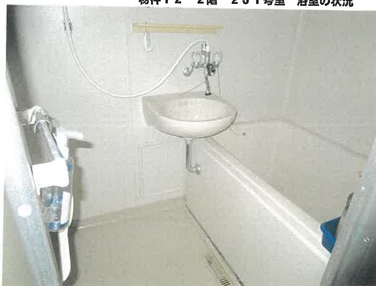
物件12 2階 201号室 浴室の状況
