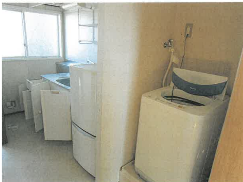
物件10 2階 205号室 ダイニング・キッチンの状況
