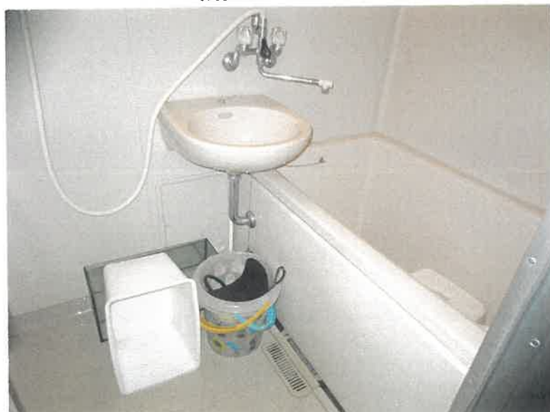
物件10 1階 105号室 浴室の状況
