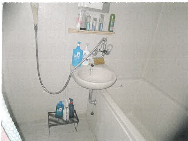
物件11 1階 103号室 浴室の状況
