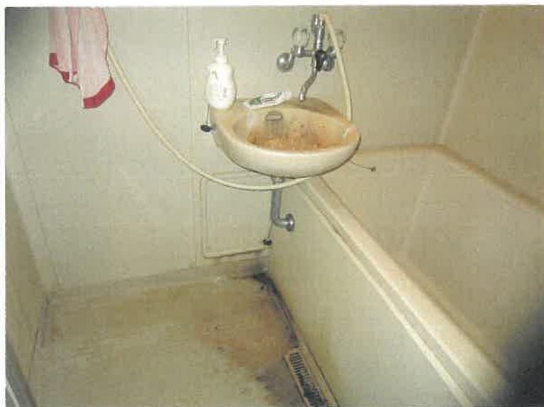
物件12 1階 103号室 浴室の状況
