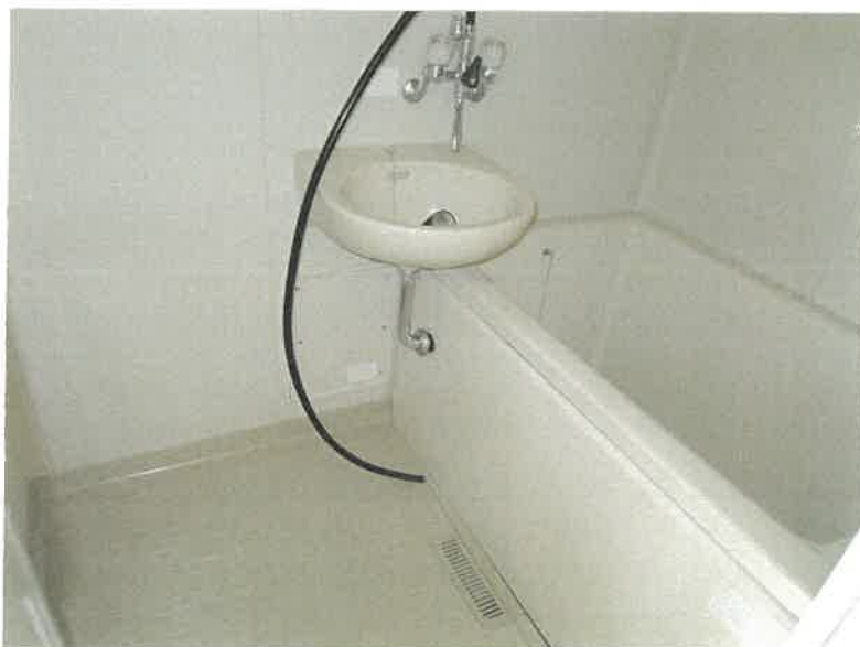
物件10 2階 201号室 浴室の状況
