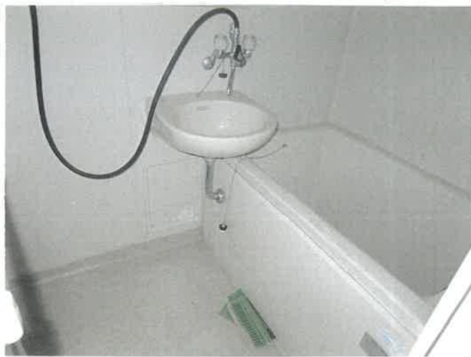
物件10 1階 101号室 浴室の状況 ⑬
