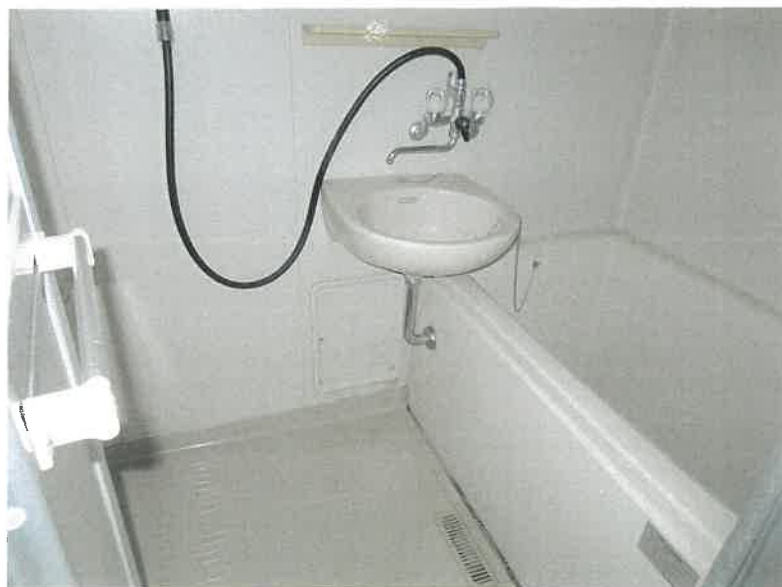
物件10 2階 205号室 浴室の状況
