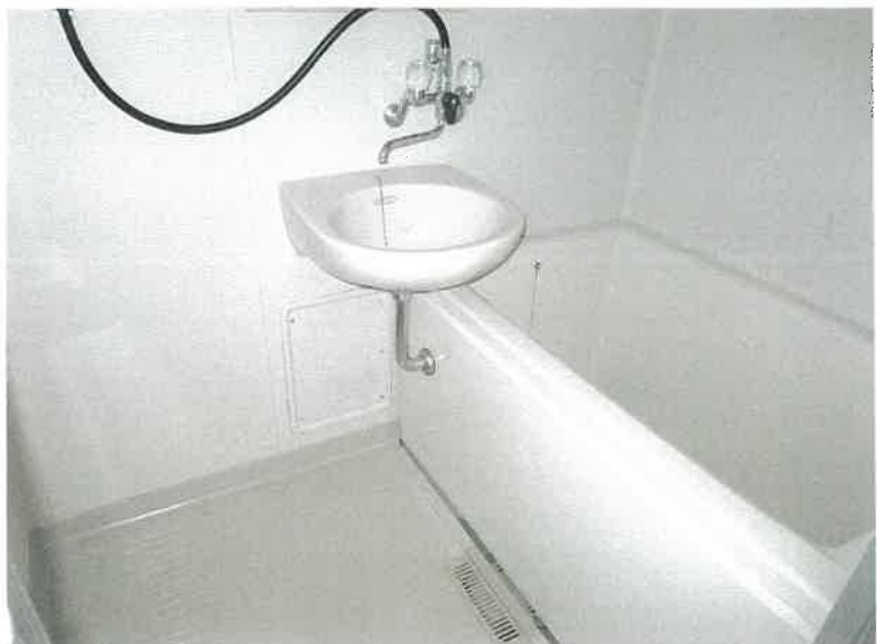
物件11 2階 201号室 浴室の状況
