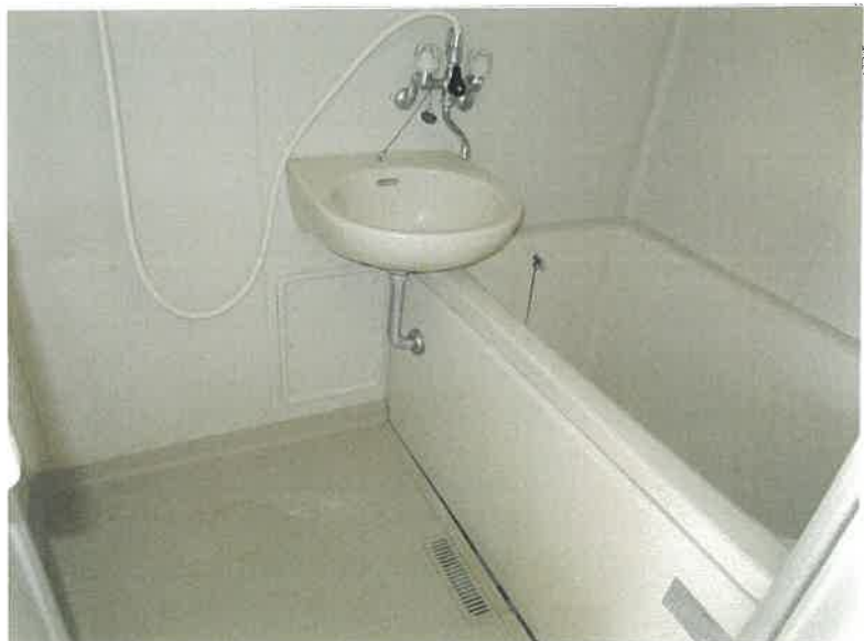
物件11 1階 203号室 浴室の状況
