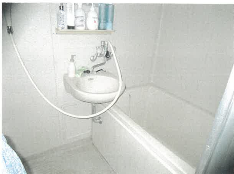
物件12 2階 203号室 浴室の状況
