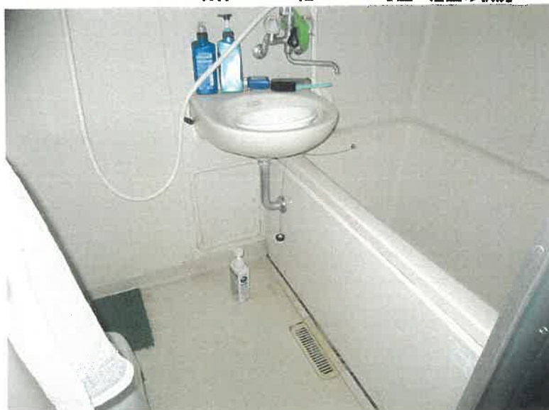
物件12 1階 102号室 浴室の状況
