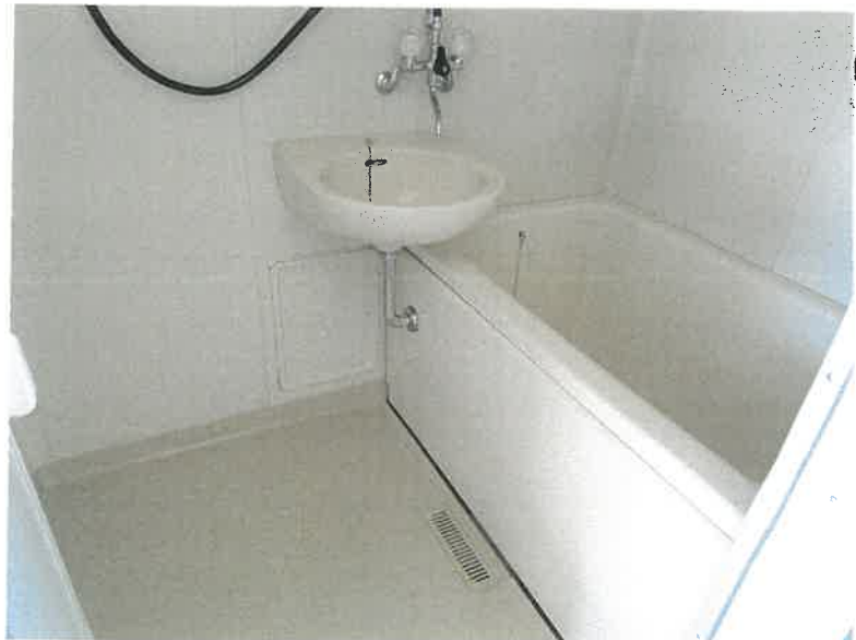
物件12 2階 202号室 浴室の状況
