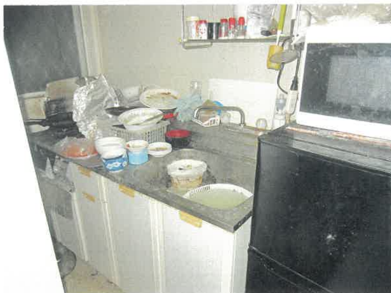
物件12 1階 103号室 ダイニング・キッチンの状況
