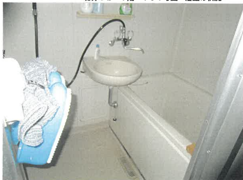
物件12 1階 101号室 浴室の状況
