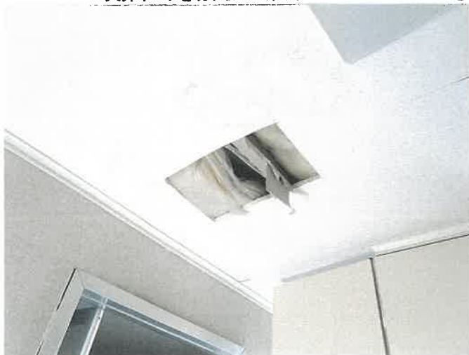
物件10 1階 101号室 ダイニング・キッチンの 天井ボードを切り取ってある状況 ⑭
