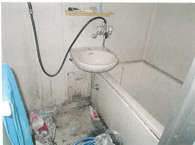
物件10 1階 103号室 浴室の状況
