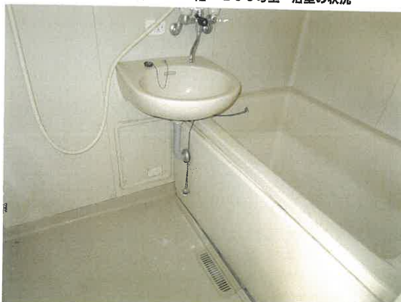
物件10 2階 203号室 浴室の状況
