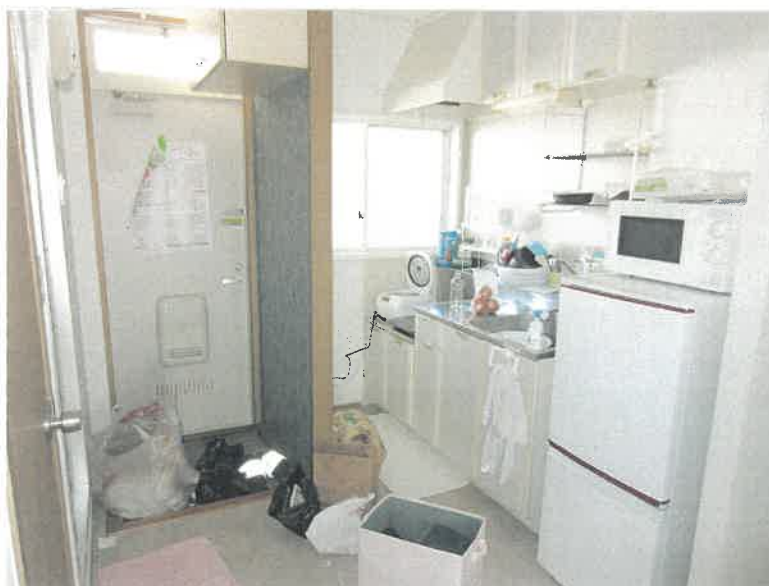
物件14 2階 202号室 ダイニング・キッチン状況
