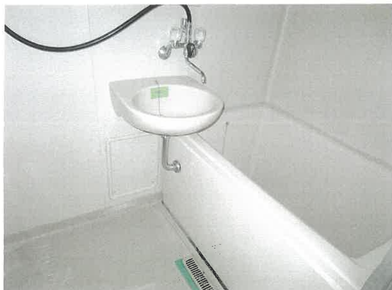
物件14 1階 103号室 浴室の状況
