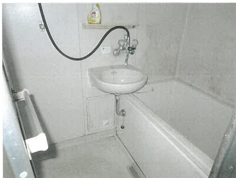
物件15 1階 103号室 浴室の状況
