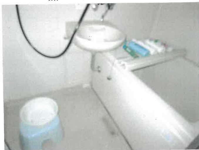
物件15 2階 202号室 浴室の状況
