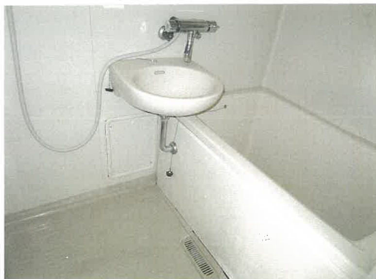
物件14 1階 203号室 浴室の状況
