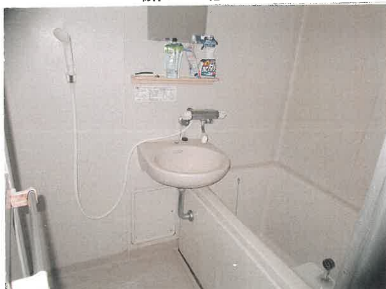
物件14 1階 102号室 浴室の状況
