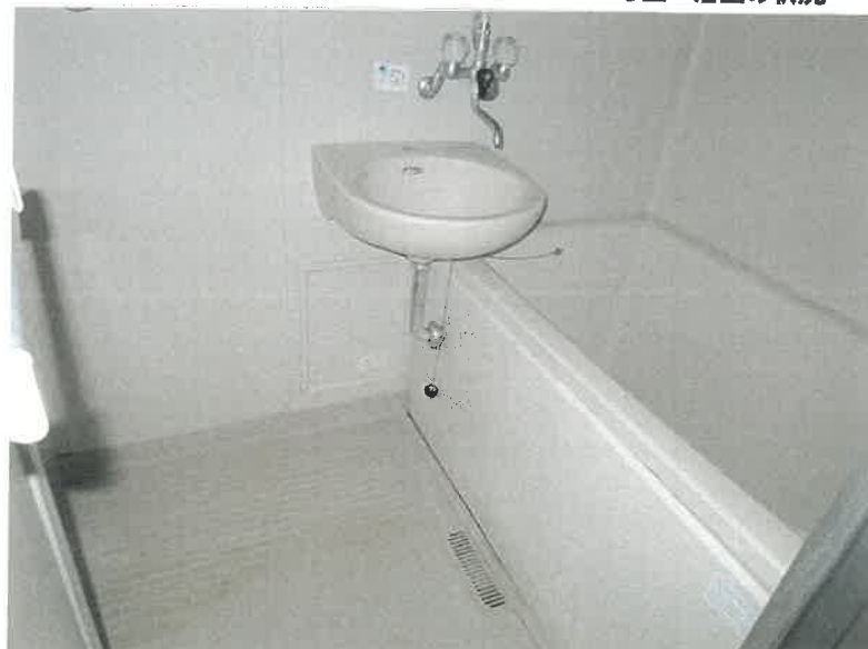
物件15 1階 101号室 浴室の状況
