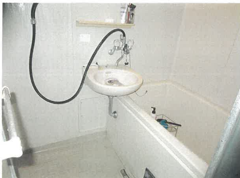
物件14 1階 101号室 浴室の状況
