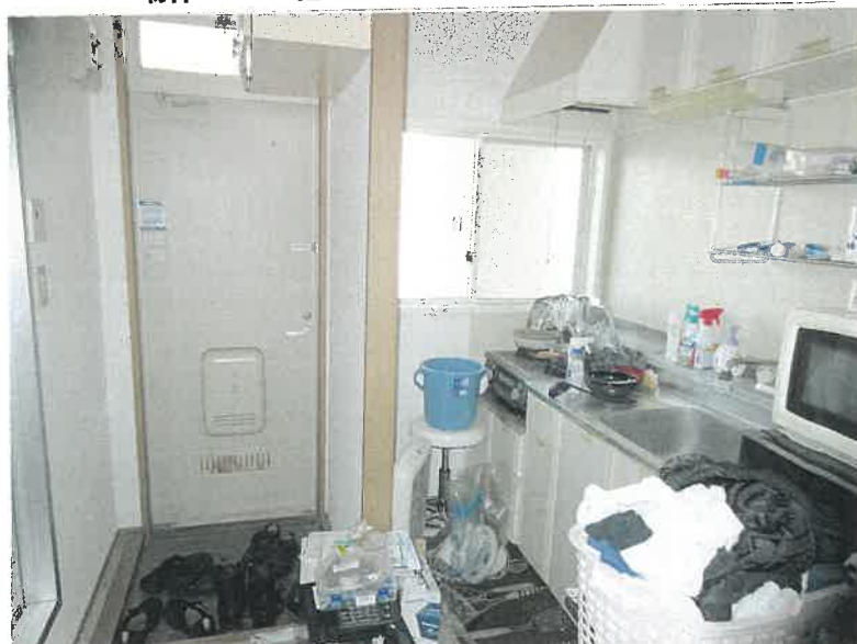
物件14 1階 102号室 ダイニング・キッチンの状況
