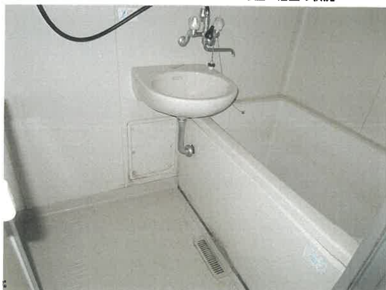
物件14 2階 201号室 浴室の状況
