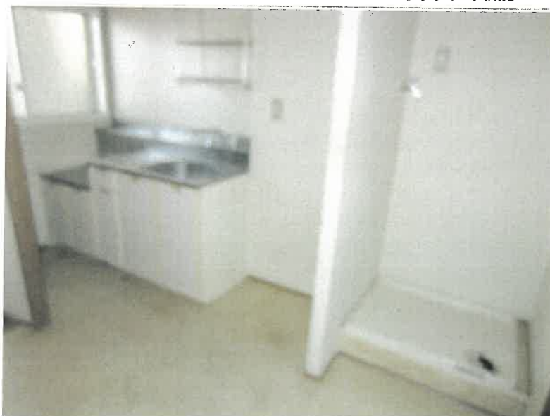
物件15 1階 103号室 ダイニング・キッチンの状況
