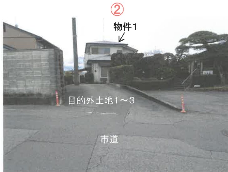
市道側からの外観
