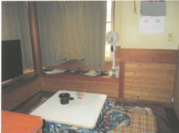
写 真 5 (リビング汚損状況1)
