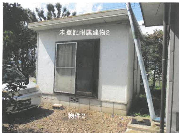
写真5（主である建物 玄関1）
