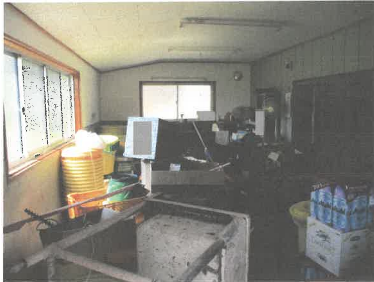
写真11 (コンクリート部分が521番4土地に越境している可能性がある状況)
