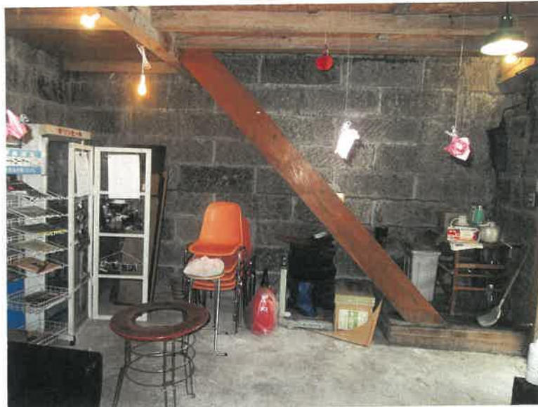
物件2 1階 階段部分の状況
