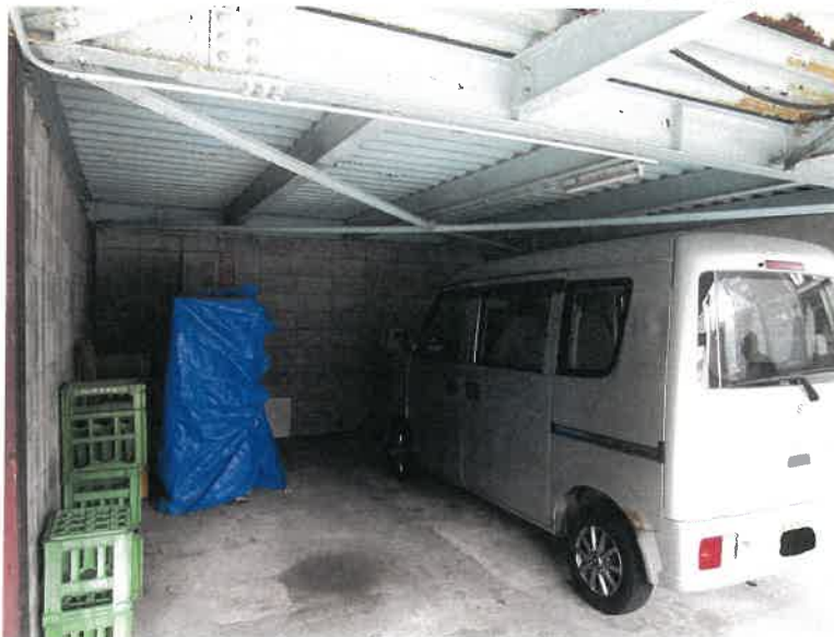
物件3 地下1階 車庫の状況
