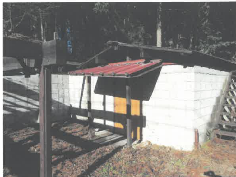
写真2 (未登記附属建物)
