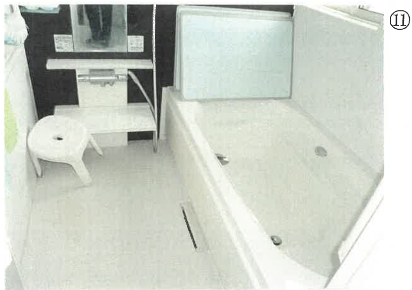
物件2主である建物 1階 浴室の状況
