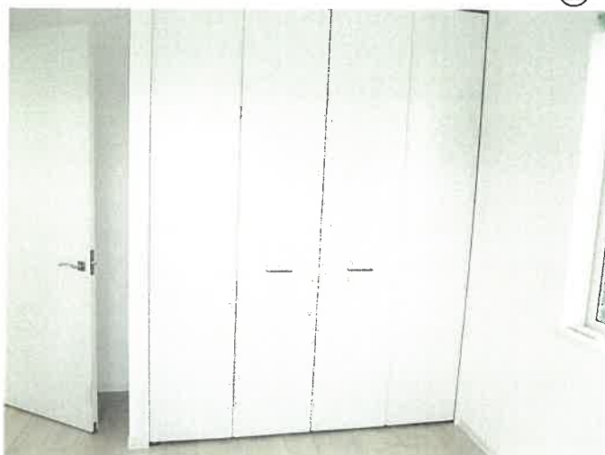
物件2主である建物 2階 洋室の状況 ⑭
