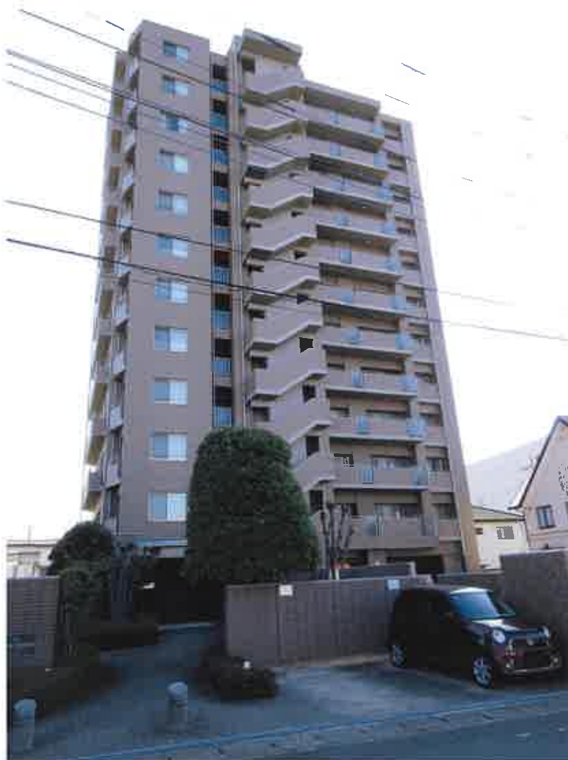
一棟の建物の外 観（建物の北西 側面を撮影）
