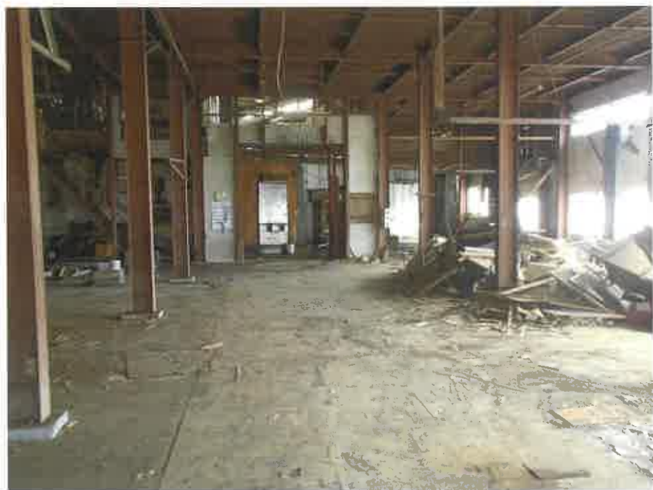
建物内の状況
