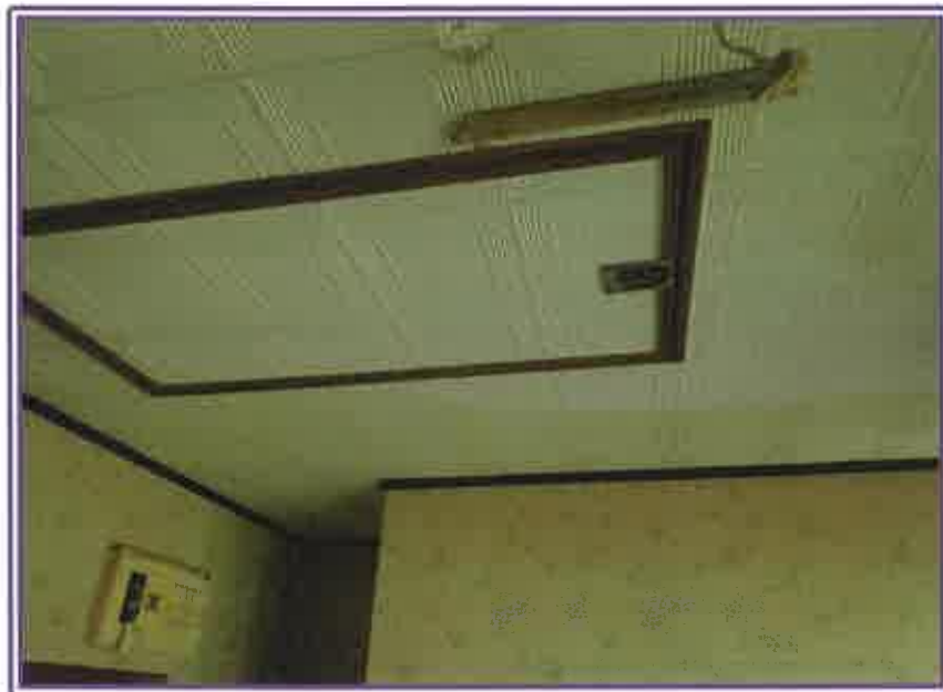
ダイニングキッチン天井に設けられた屋根裏収納入口と思われる部分
