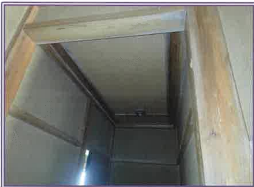
屋根裏収納入口部分
