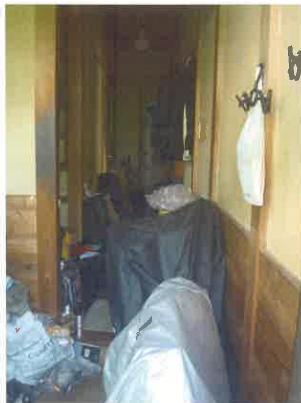
建物内の状況
