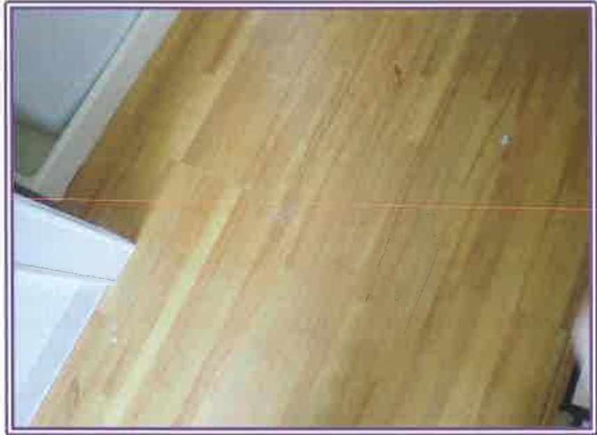
308号室廊下の修繕跡が認められる箇所
