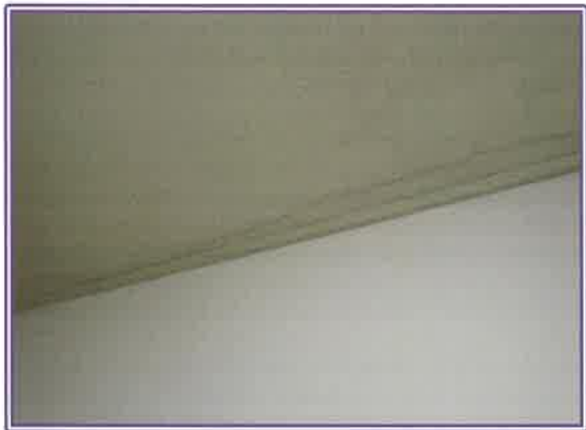
105号室D・K天井に認められるクラック
