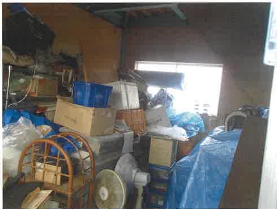
建物内の状況
