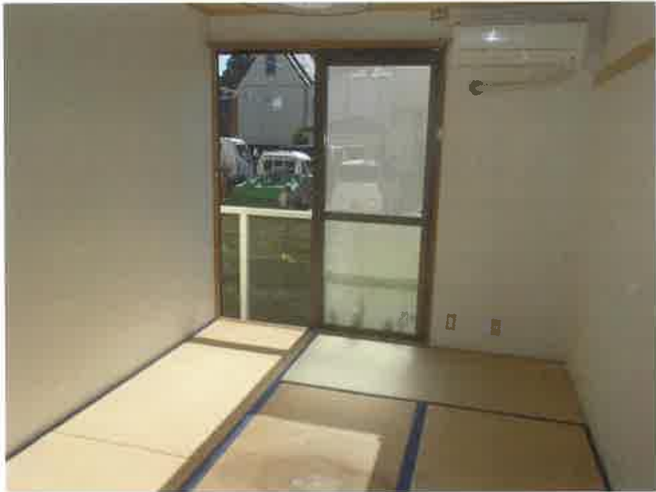
建物内の状況
