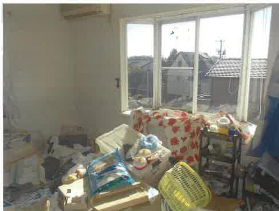
建物内の状況
