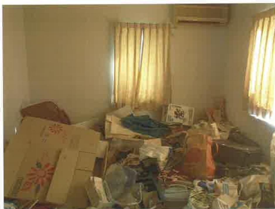
建物内の状況
