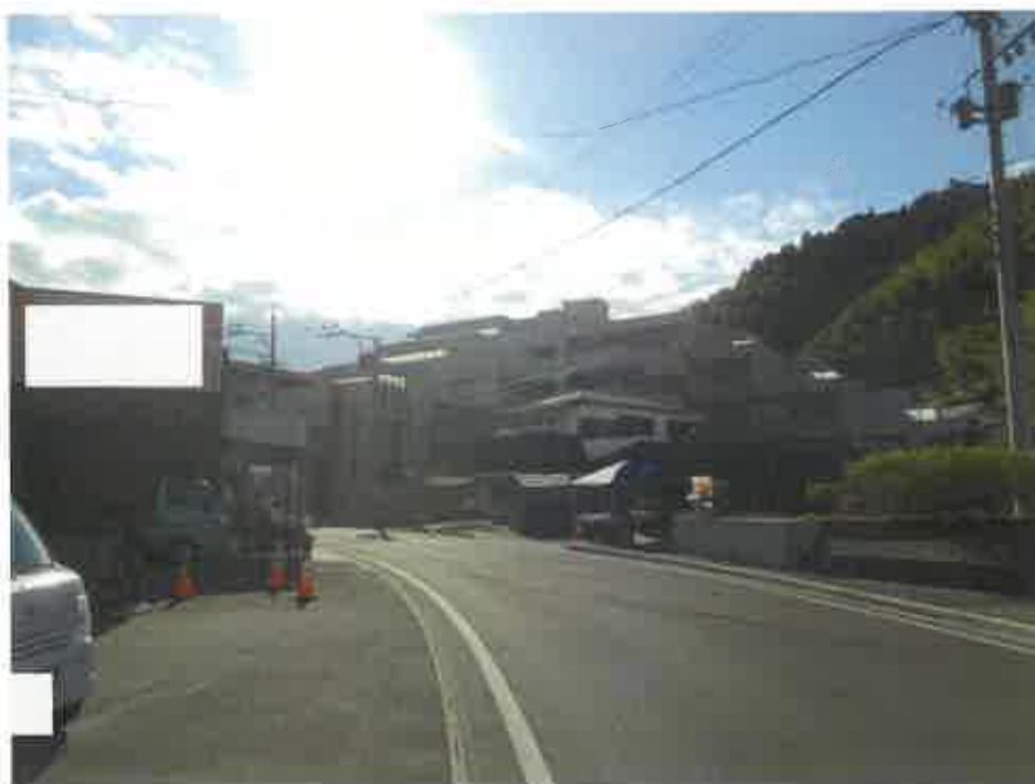
本件建物を含む一棟建物
