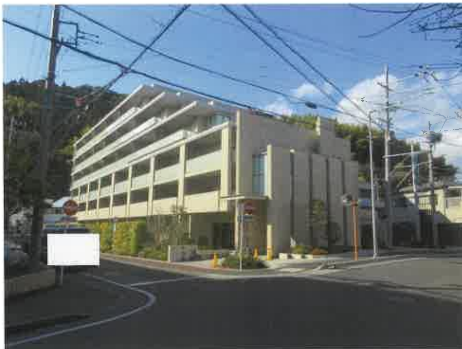
本件建物を含む一棟建物
