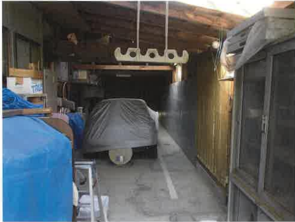
建物内の状況
