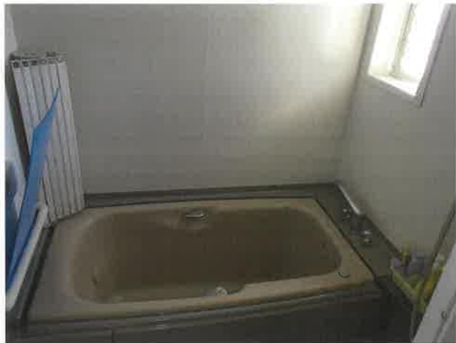
建物内の状況
