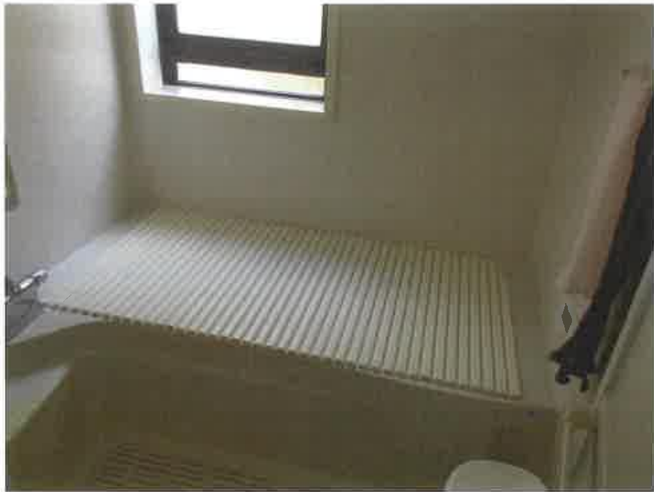
建物内の状況
