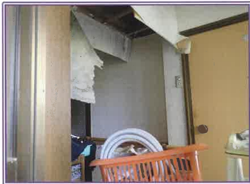
トイレ付近廊下の天井
