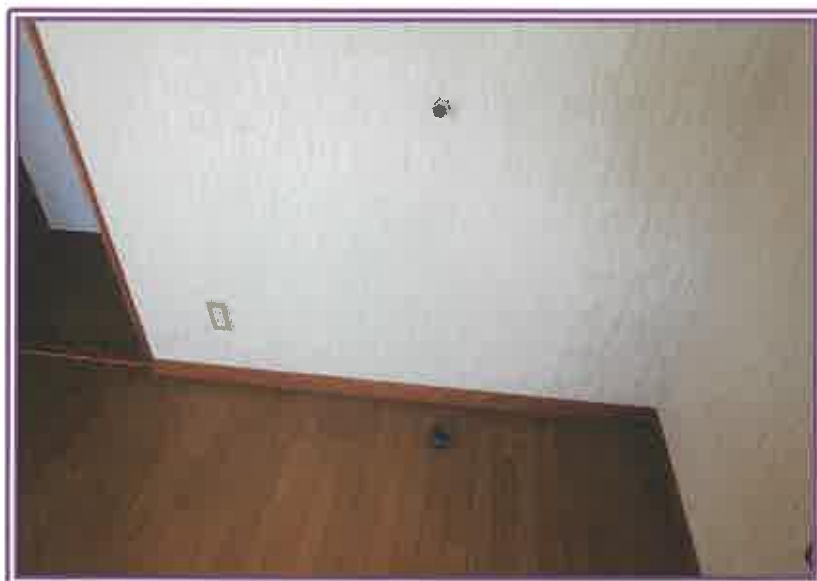
壁及び床から突き出た管
