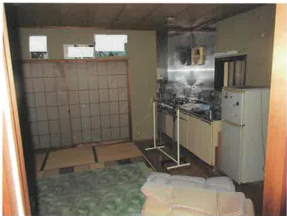
建物内の状況
