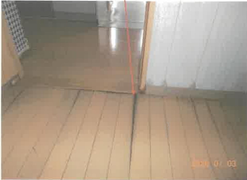
写真 1 5 本件建物 2 階ホール付近の床部分に犬の排尿による染み跡等 (撮影位置の図示は省略)
