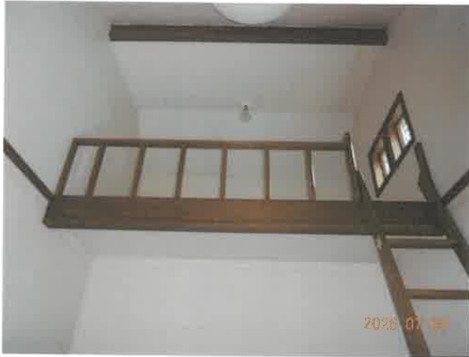
写真 1 1 本件建物 2 階東側洋室のロフト
