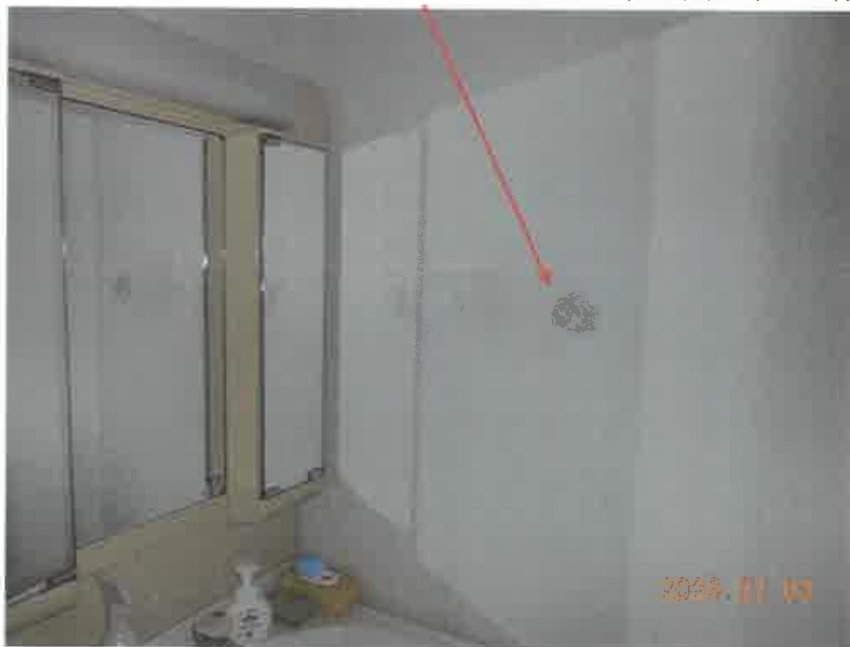
写真5 本件建物1階洗面所の内壁クロスの損傷箇所（撮影位置の図示は省略）
