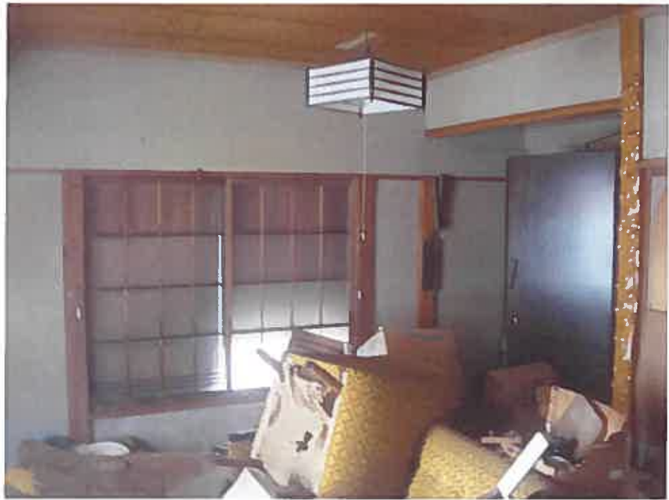
建物内の状況
