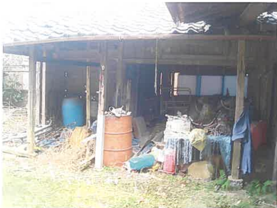
建物内の状況
