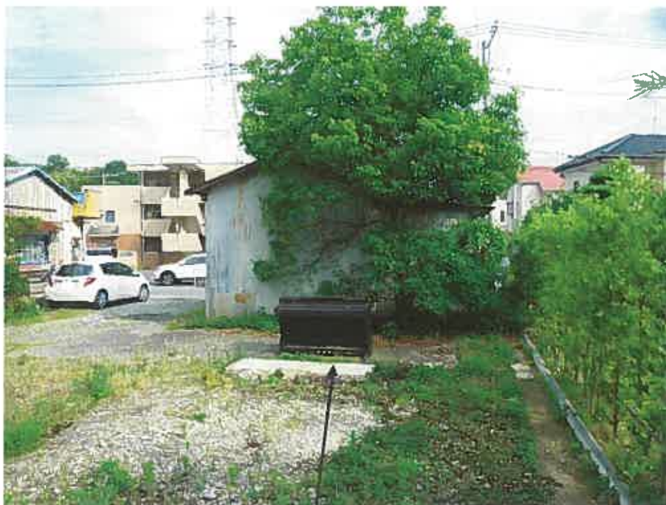
コンクリート構造物
