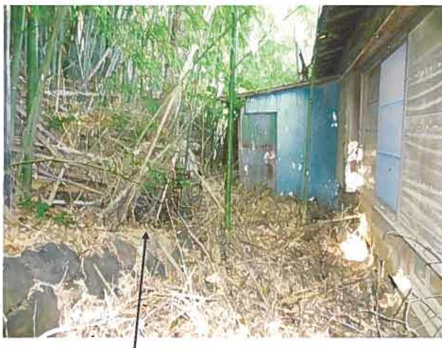
北西側隣接地への進入口と考えられる部分
