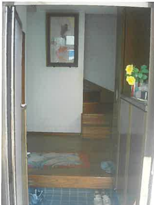
建物内の状況
