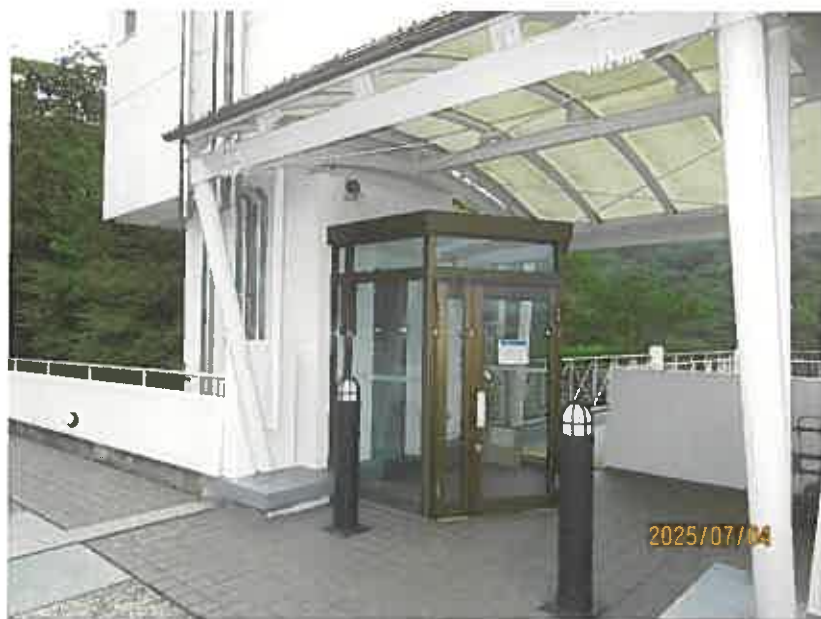
写真7 本件マンション出入口（7階部分）
