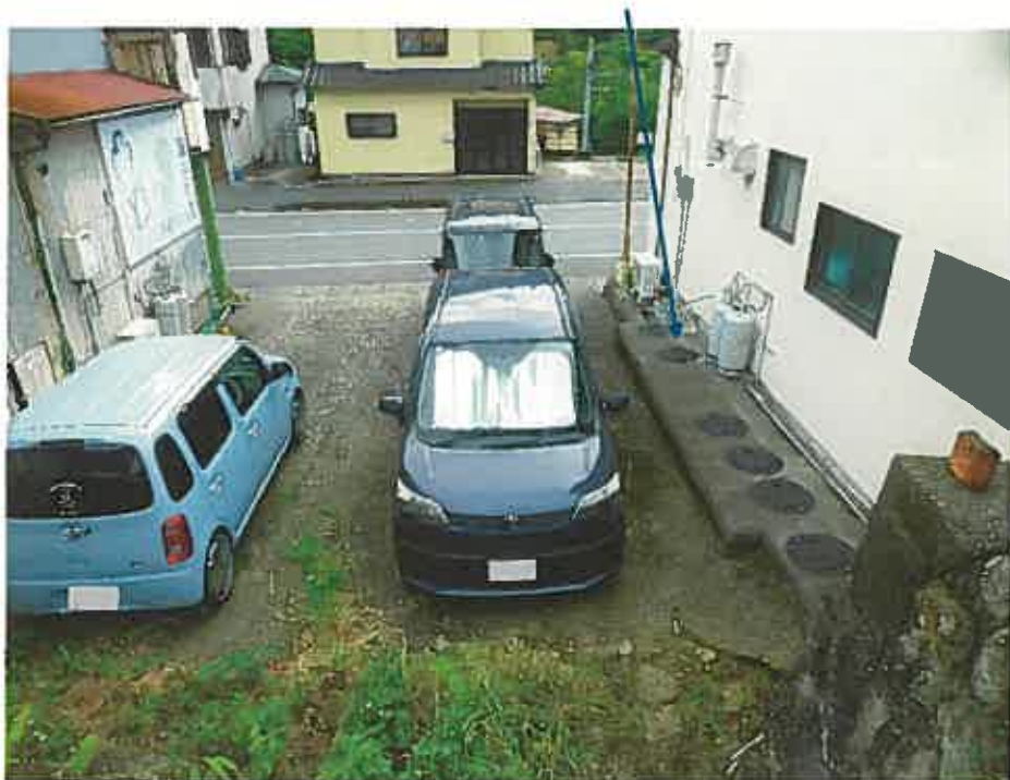
北西側隣接建物の浄化槽
