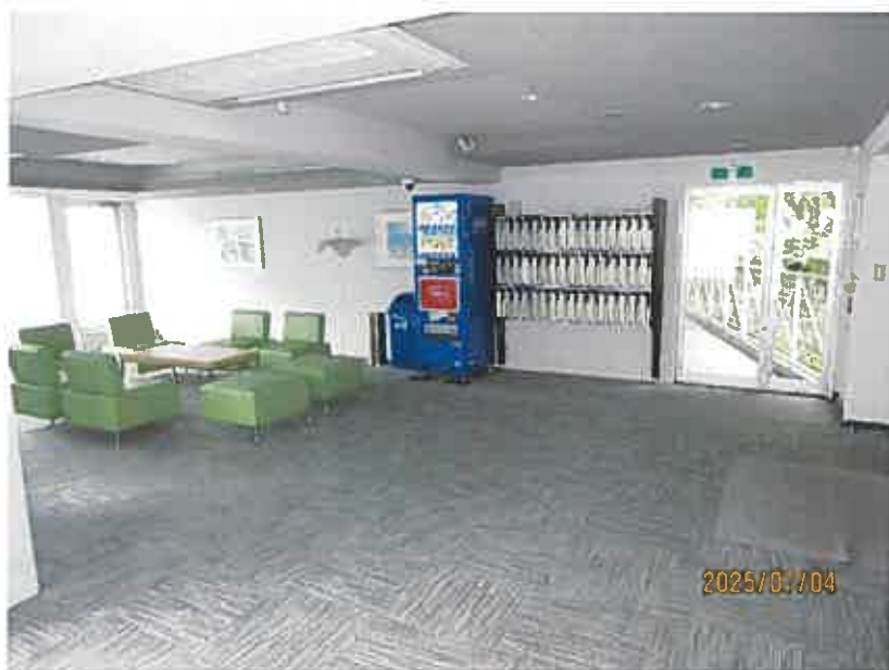
写真8 本件マンションエントランス①
