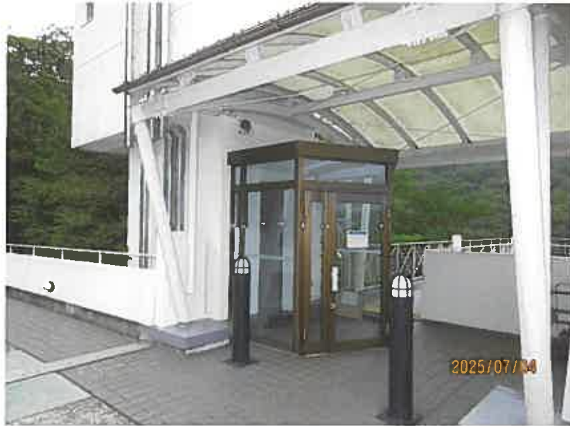
写真7 本件マンション出入口（7階部分）
