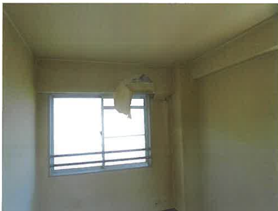
写真16 301号室洋室の雨漏り跡
