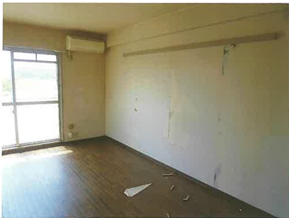
写真17 301号室リビング
