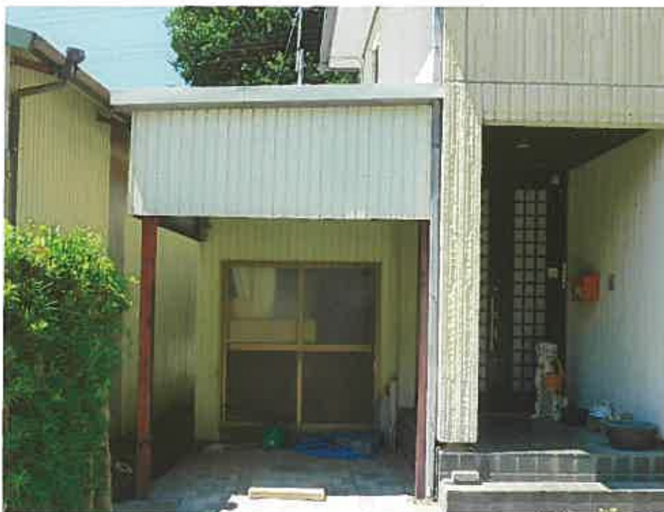
写真3 物件1 建物増築部分
