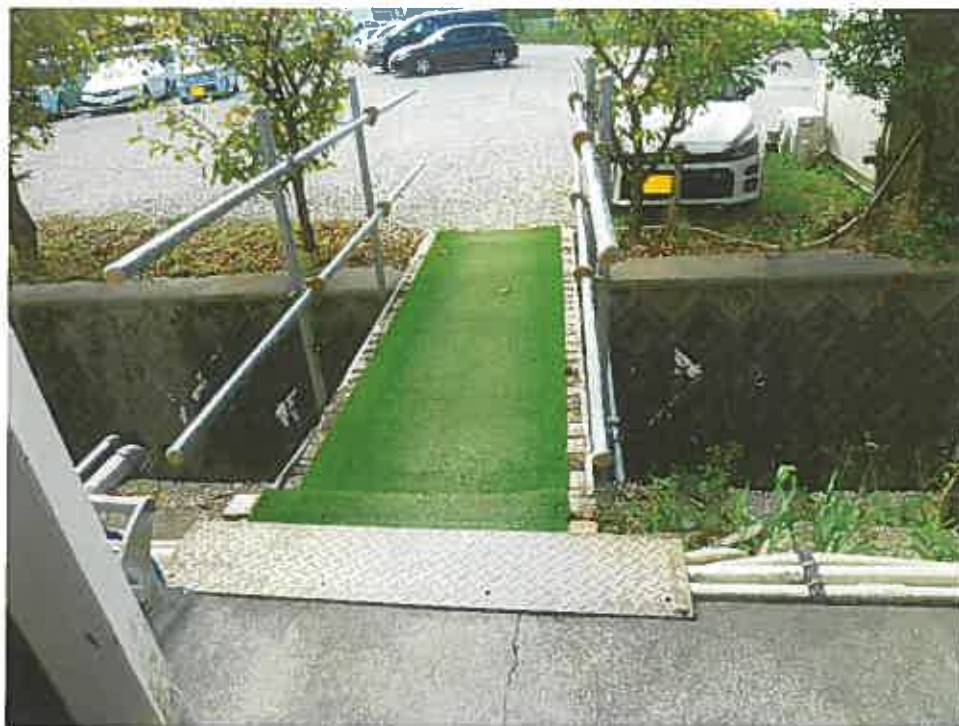
写真7 南西側隣接地との間の水路に架けられた簡易な橋
