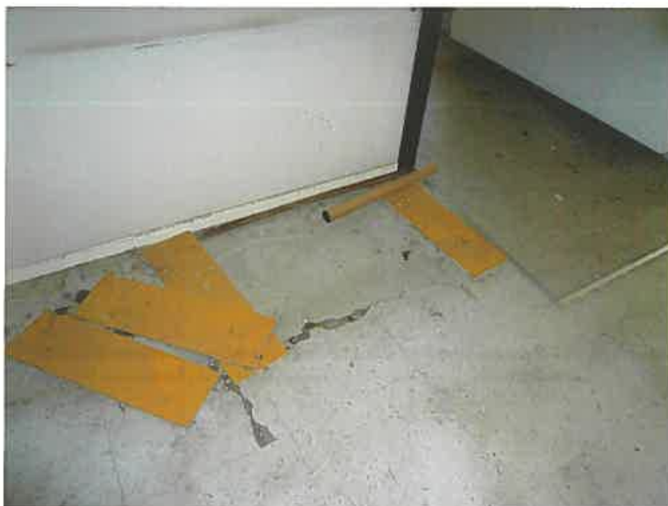
写真 1 2 物件 2 主である建物内の床が抜けている箇所
