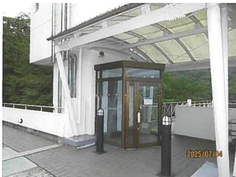
写真7 本件マンション出入口（7階部分）
