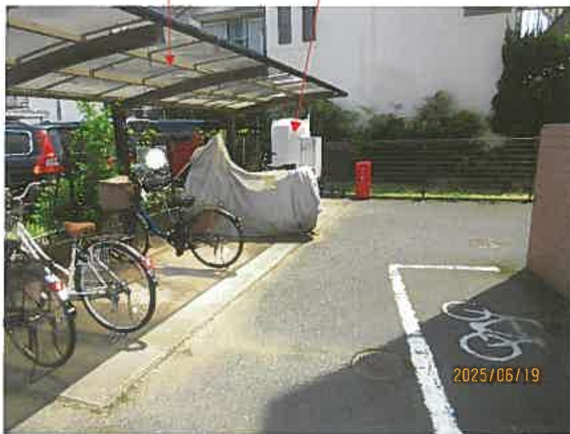
写真5 駐輪場 ガスタンク
