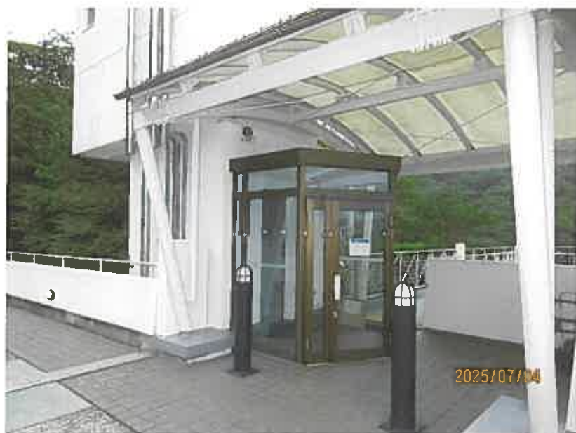
写真7 本件マンション出入口（7階部分）
