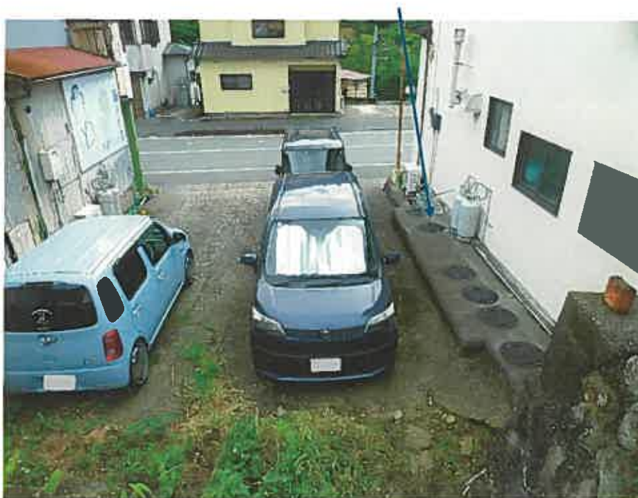
北西側隣接建物の浄化槽
